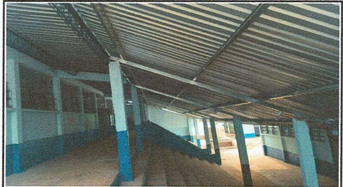
Foto 2: Panorámica corredor de escuela trabajos finalizados.
